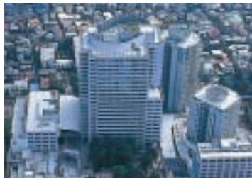
本社 (文京グリーンコート・センターオフィス 19階、20階)
