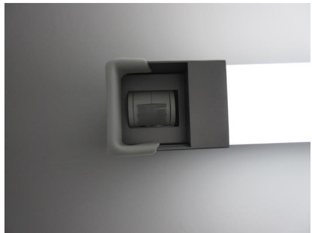
高田馬場事業所の非常階段に設置されているLED照明と人感センサー。不在時には照度が落ちる。
